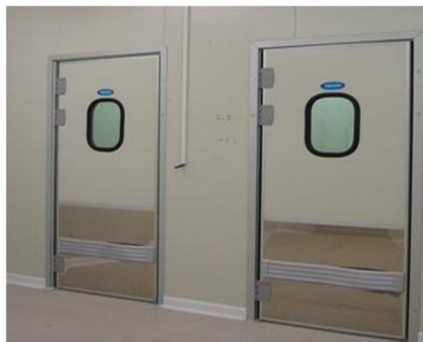
Двери технические маятниковые выполнены методом наполнения полиуретаном плотностью  $43 \text{ кг/м}^3$  и толщиной 40 мм. Полотно двери изготавливается из стального листа с полиэстерным покрытием (Food Safe), который соответствует требованиям санитарно-пищевой отрасли. Профиль рамы полотна, коробка и притворный Г-профиль выполнены из анодированного алюминия. Реверсивные петли с возвратным механизмом позволяют поворот в обе стороны ( $180^\circ$ ).
