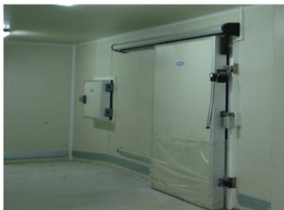
Двери для минусовых температур с электрообогревом выполнены методом наполнения полиуретаном плотностью 43 кг/м<sup>3</sup> и толщиной 120 мм. Полотно двери изготавливается из стального листа с полиэстерным покрытием (Food Safe), который соответствует требованиям санитарно-пищевой отрасли.
